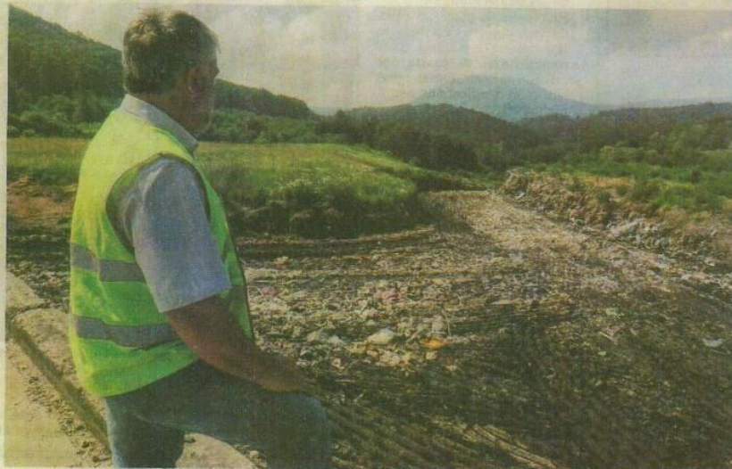
Les membres de l'ADEAP ont passé, à Châtenois et alentour, un été insupportable en raison des fortes odeurs du centre de stockage des déchets. Et mettent en avant des risques sanitaires. PHOTO ARCHIVES DNA - FRANCK DELHOMME
