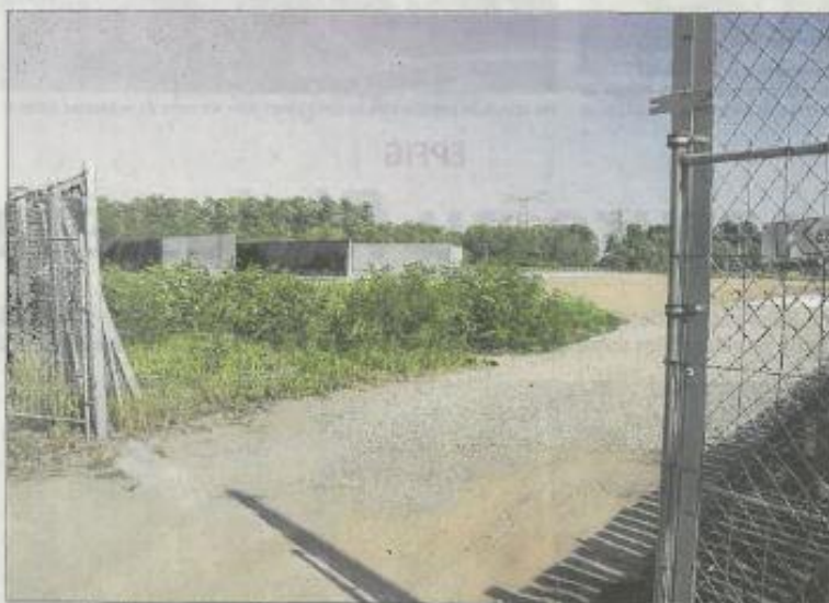
La construction d'une unité de méthanisation à Scherwiller, juste à côté du Smictom d'Alsace centrale, suscite de nombreuses interrogations de la part des riverains.
